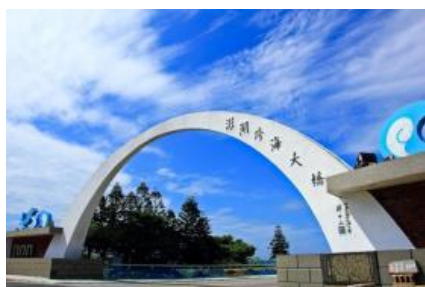
澎湖跨海大橋
