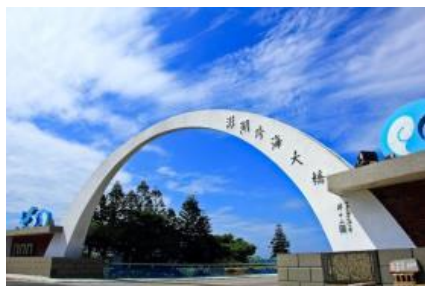
澎湖跨海大橋
